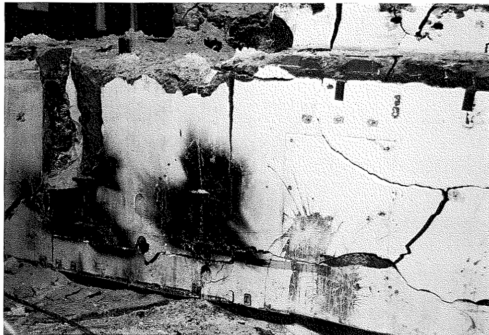
Bild Nr. 7: Chemische Sprengung des Zellenfundamentes
