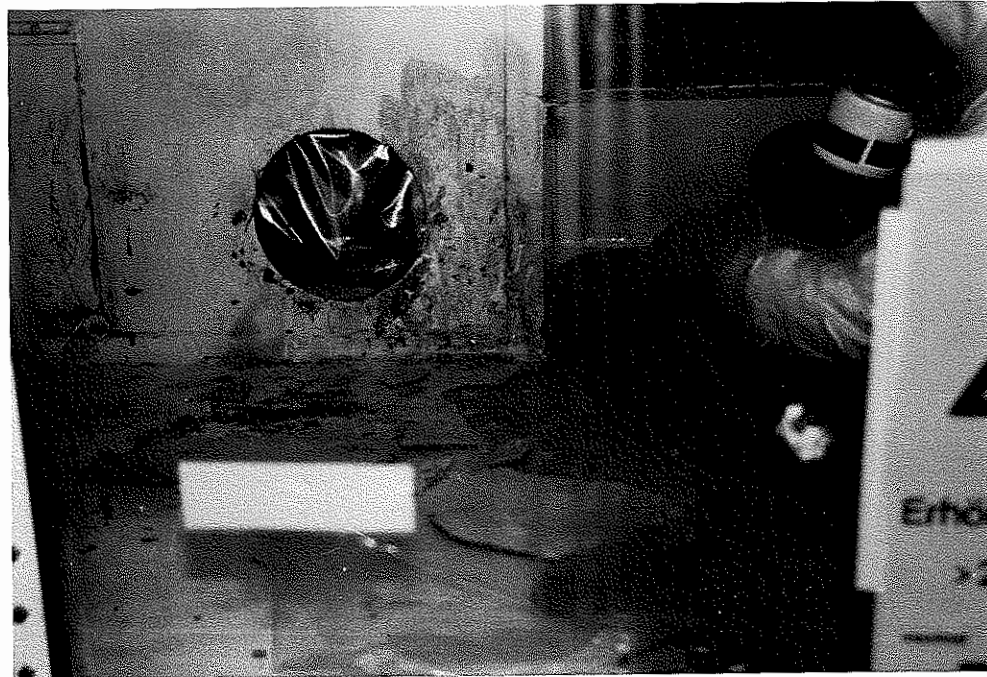
Bild Nr. 6: Abstemmen der Bodenvergußmasse
