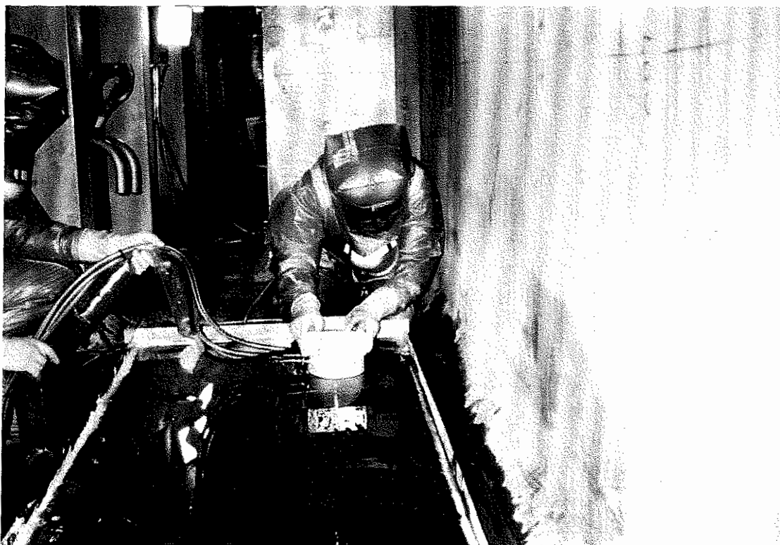
ELECTRODECONTAMINATION DU PLANCHER
