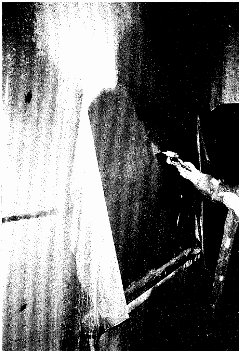
RINCAGE APRES PULVERISATION DE GELS OXYDANTS
