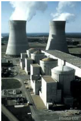
Traditionnal cooling tower
